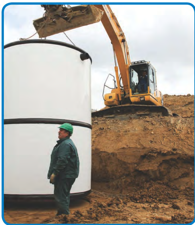
Einbau einer 220 EW Kläranlage für das Dorf Remlin bei Rostock im Oktober 2011
